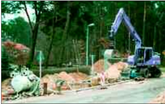
Die Abwassererschließung in der Angermünder Straße, 1999
