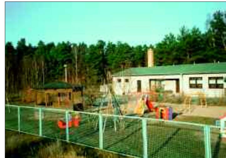
Die Kindertagesstätte „Pittiplatsch“, Althüttendorf
