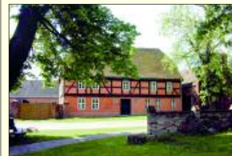
Das Lehn schulzenhaus ist nach der Restau- rierung ein Prachtstück
