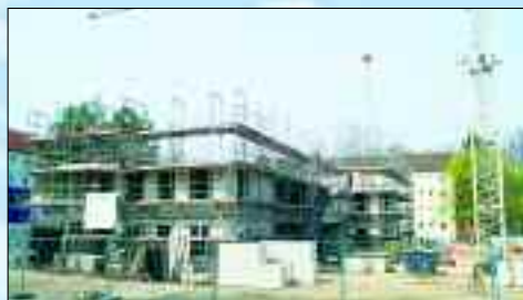
Der Rohbau entsteht: Quartier am Märchenwald.
