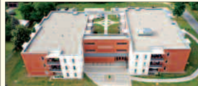
Kiez Karree: Neubau von 46 altersgerechten Wohnungen.
