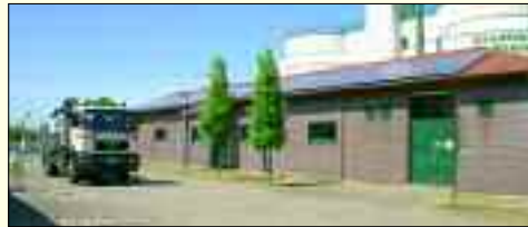
Klärgasgewinnung – Photovoltaikanlage – Blockheizkraftwerk
