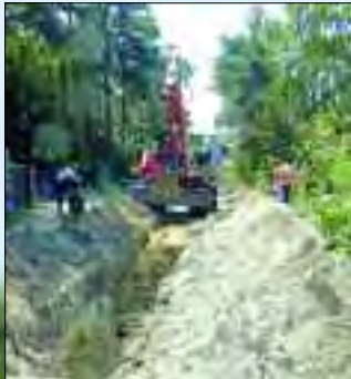
Mit schwerem Gerät werden neue Leitungen gelegt.
