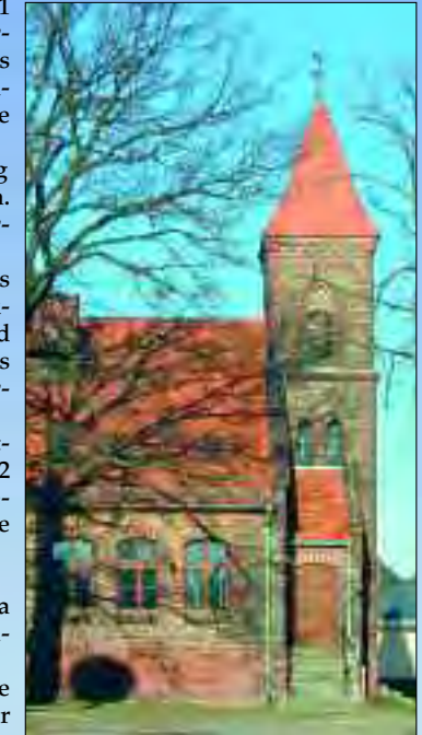
In den letzten Jahren wurden umfangreiche Sanierungsarbeiten an der Kirche durchgeführt
