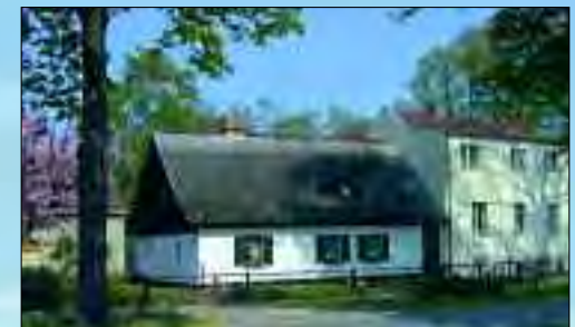
Eines der Häuser in dem die Weber wohnten, hier sogar mit Reed gedeckt
