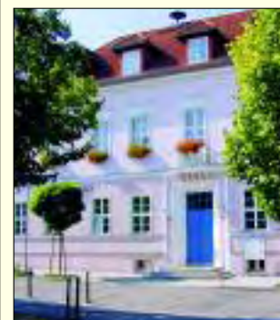
Das Bürgerbüro befindet sich zentral im Rathaus der Stadt
