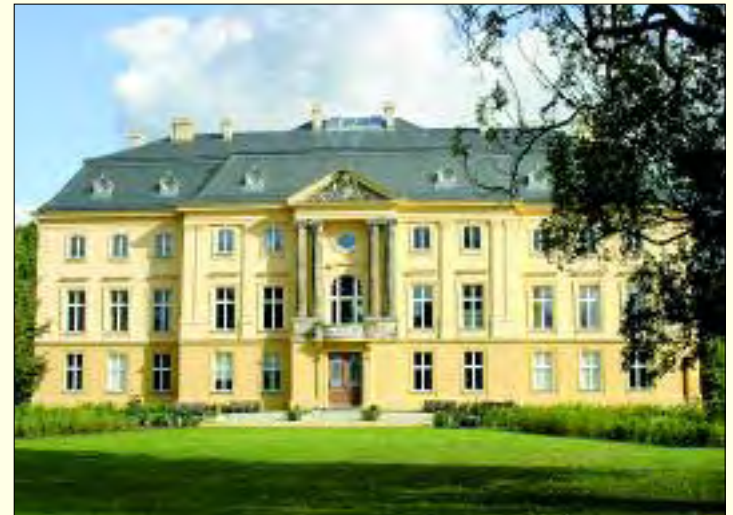
Der Verein „Schloss Trebnitz Bildungs- und Begegnungszentrum e.V.“ übernahm seit seiner Gründung 1992 Instandsetzungs- und weitere Bewirtschaftungsarbeiten und nutzt es heute vielfältig
