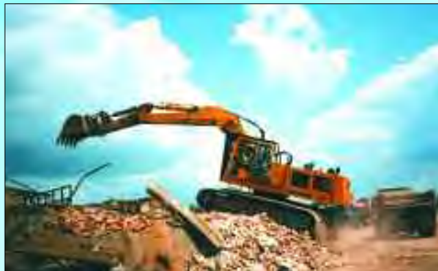
Die Abrissreste eines Hauses werden nun abgefahren
