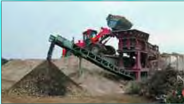
Bauschutt und Betonbruch werden in der eigenen Brecher- und Siebanlage zerkleinert, vom Schrott befreit und recycled
