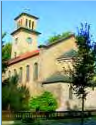
Die 1852-1855 erbaute Martin-Luther-Kirche im historischen Teil Hennigsdorfs
