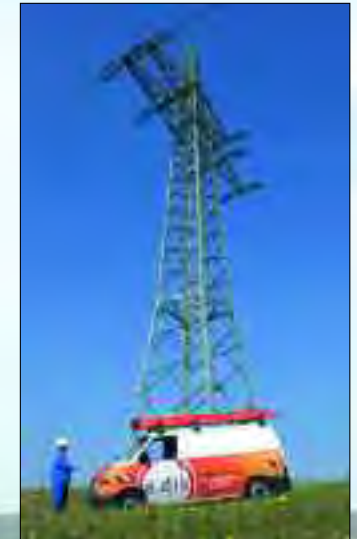
Auch das ist eine wichtige Aufgabe, die Überwachung und Instandsetzung der Freileitungen
