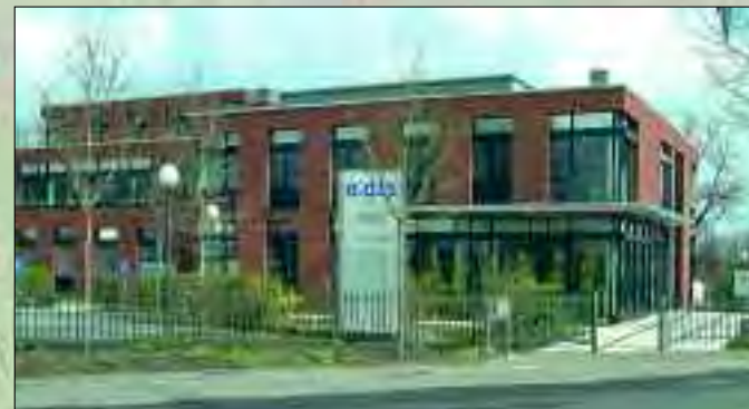
Bei Fragen, Problemen oder Aufträgen stehen für Kunden und Elektroinstallateure das Regionalzentrum Fürstenwalde zur Verfügung
