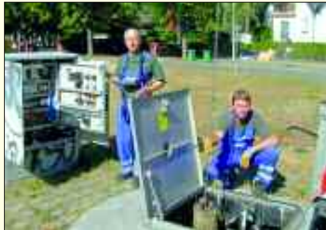
Peter Hirschmann und Steffen Lauschke bei der Wartung des Abwasserpumpwerkes in Eichwalde, Am Stern
