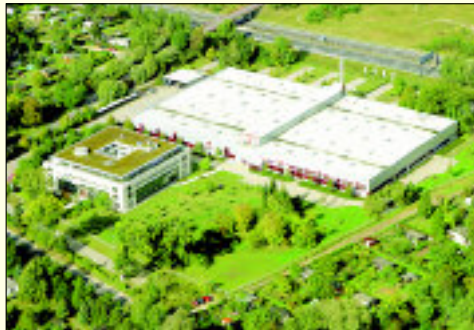
Blick auf das Firmengelände
