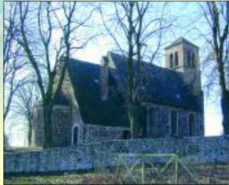
Eine besondere Kirche, die Kirche von Wegendorf – sie ist gebaut aus Granitfindlingen
